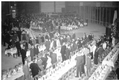
Statens Vattenfallsverks 50 årsjubileum 1959 firades, på många platser i landet, så även i Järkvissle. Bilden är från den sedan länge rivna stora maskinhallen. Festen pågick till kl. 01.00. Det var snöyra utomhus denna historiska afton. Foto: Paul Nilsson.
