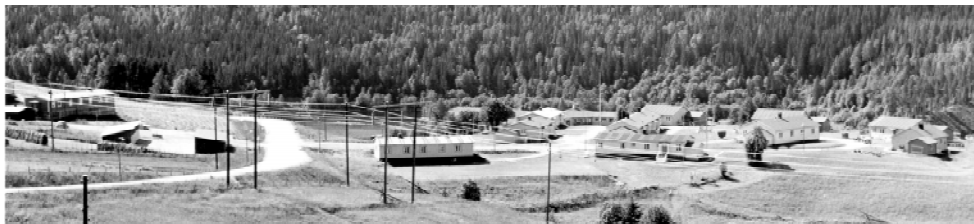
Övre anläggningsbyn vid Järkvissle kraftstation i slutet av 1950-talet. Tjänstemannamässen är mitt i bilden och längst bort. Idag återstår endast de byggnader som bildar den nuvarande Trollbyn. Foto: Algot Lidberg.
